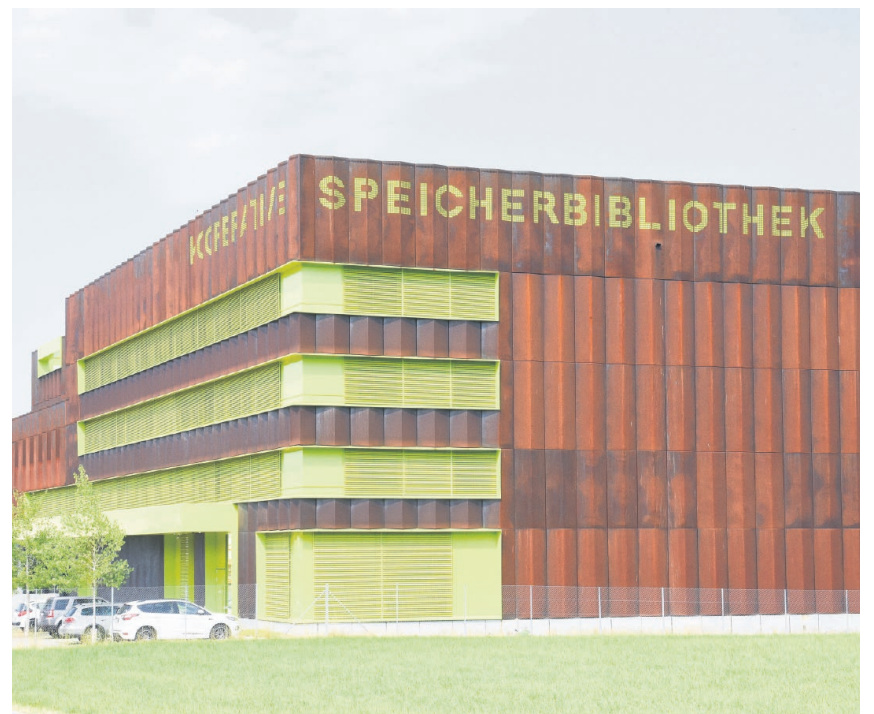
Die Fassade der Speicherbibliothek besteht aus Cortenstahl.
